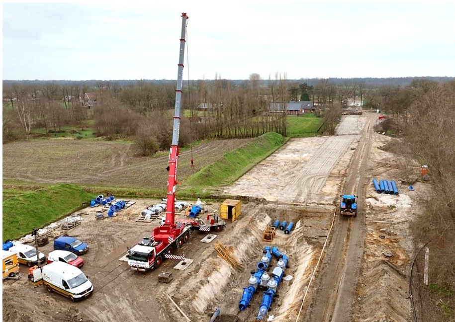
Aanleg transportleidingen nabij pompstation Ganzebos-West in Beckum
