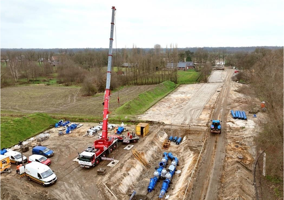
Aanleg transportleidingen nabij pompstation Ganzebos-West in Beckum
