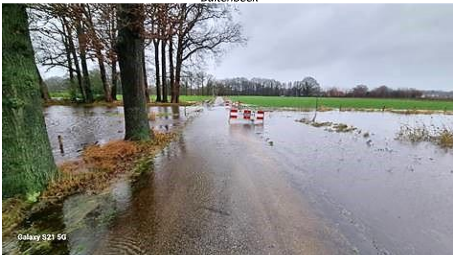
Brug over de Rotersweg, overgelopen Hagmolenbeek
