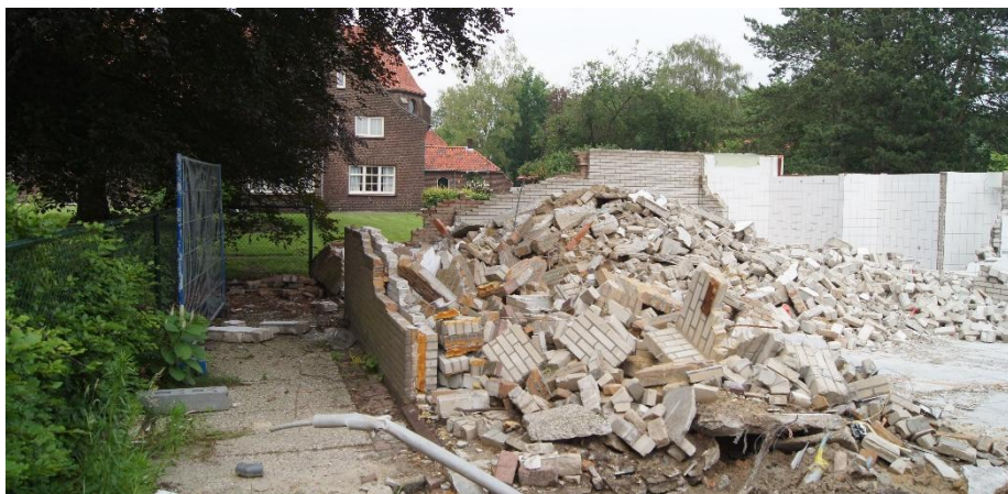
De restanten van de oude kleedkamers op de Kruudnhof. Nu geëgaliseerd en bij pastorietauin aangetrokken.
