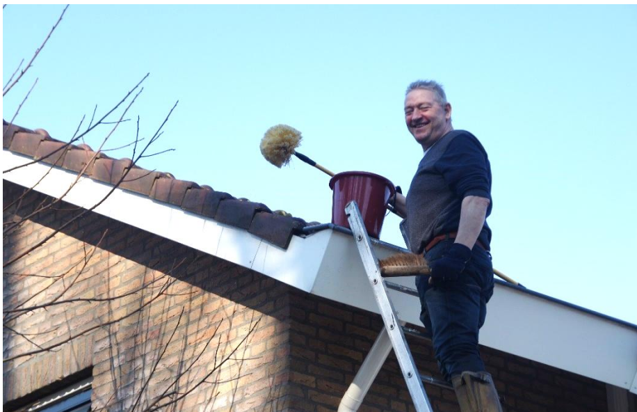
Toon Wentink aan de slag om de dakgoten schoon te maken. (Gemaakte afspraak tijdens Kerstmarkt!)
